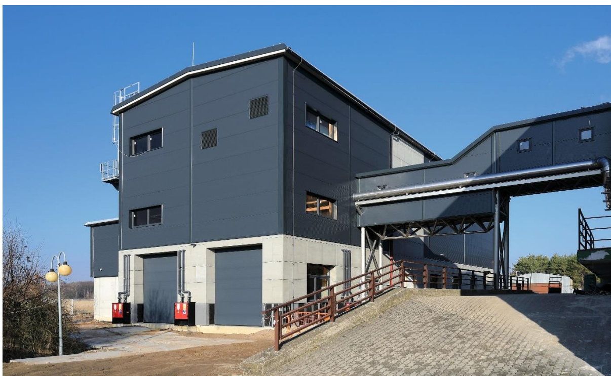
Rekonstrukce úpravny vody, Pohřebačka
