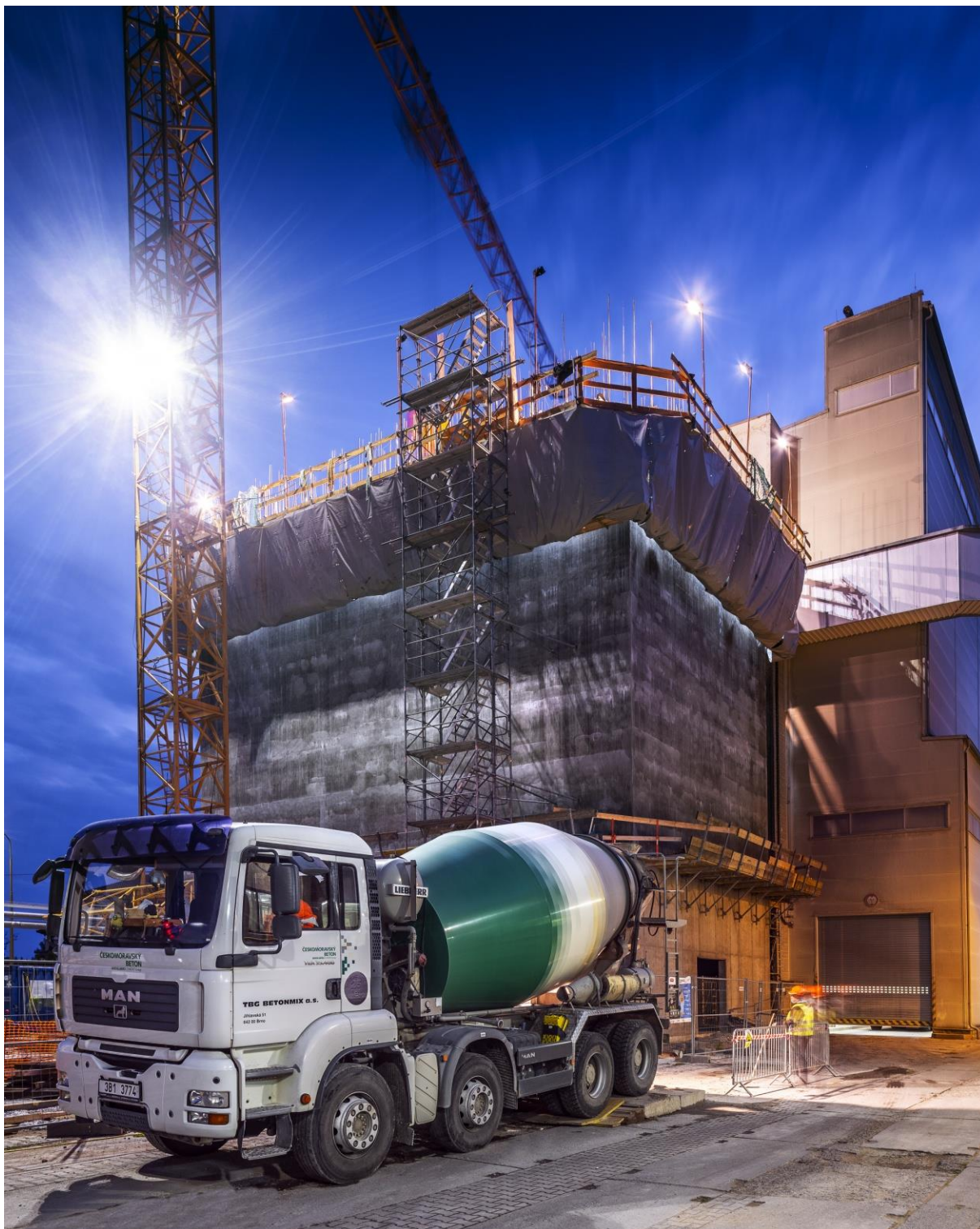
Výstavba síla společnosti GoodMills, Kyjov
